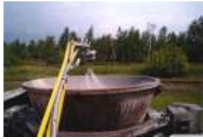
Technologie de projection d'enduits pour la protection des pots à scorie
